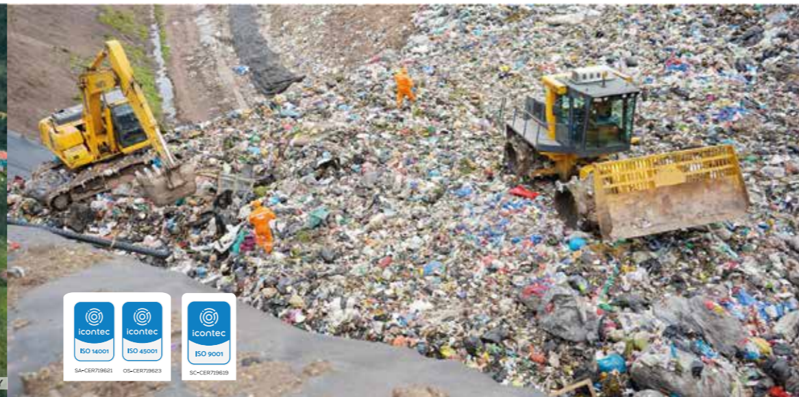
RELLENO SANITARIO DE PICHACAY
